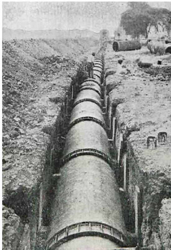
Рис. 1. Будівництво підземного газогону [41]
