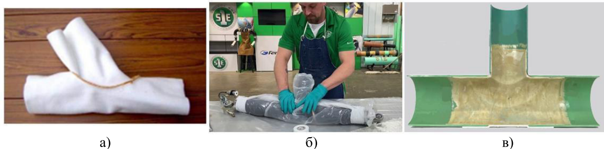
Рисунок 12 – Ремонт трійників CIPP методом
