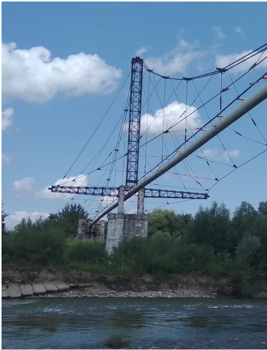
Рисунок 1 – Несучі конструкції газопроводу «Угерське – Івано-Франківськ» на ділянці надземного переходу через р. Свіча
