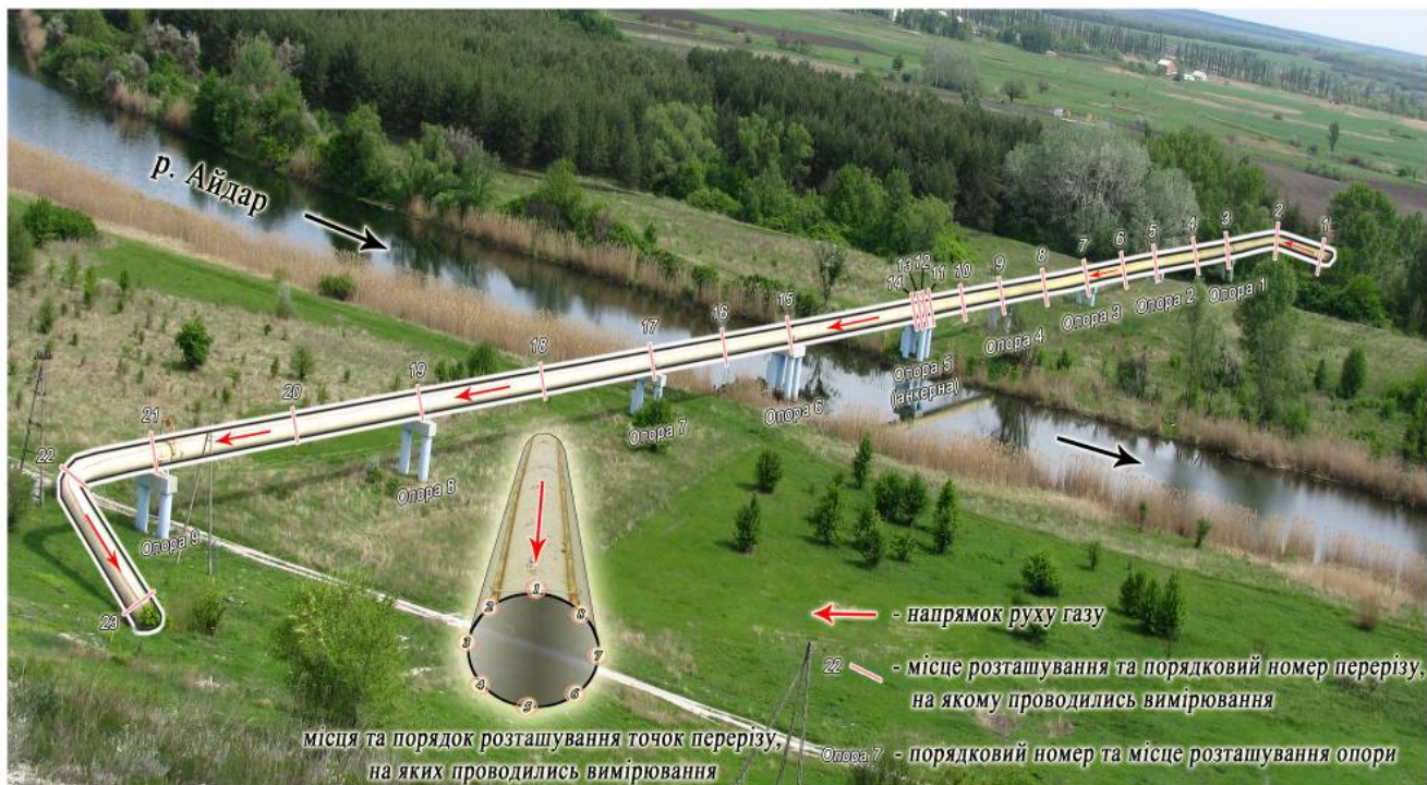
Рисунок 3.1 - Загальний вигляд ділянки повітряного переходу через р. Айдар Магістрального газопроводу «Союз»
