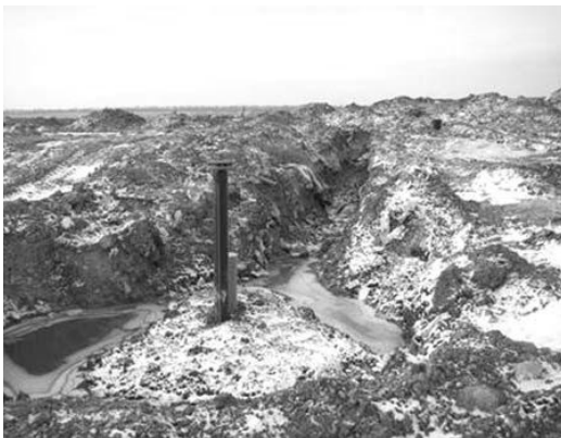
Рис. 6. Газозбірні свердловини
