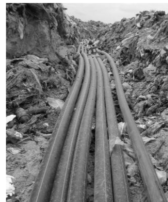
Рис. 7. Прокладання трубопроводів біогазу на полігоні ТПВ
