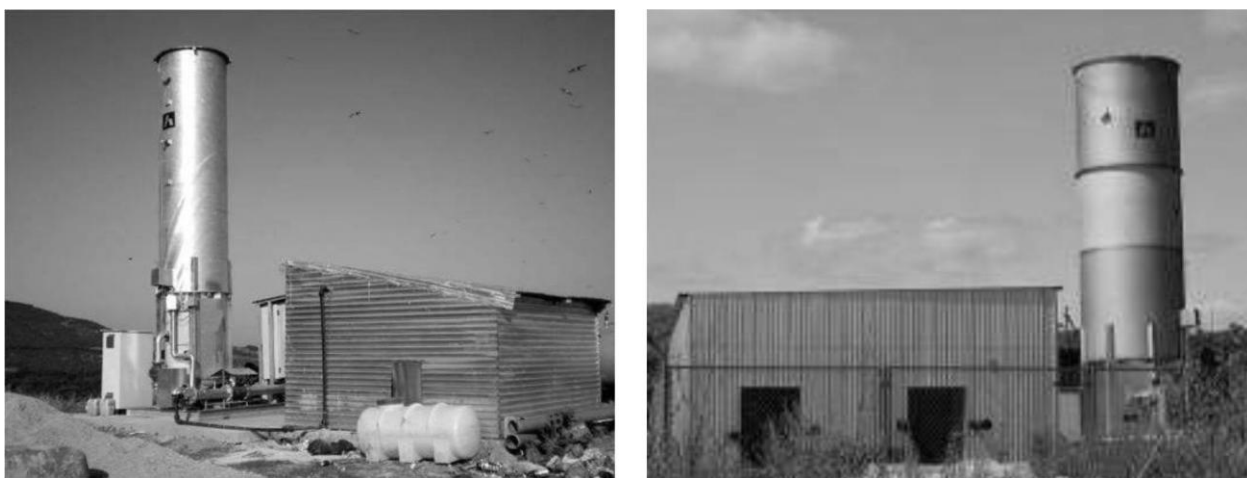
Рис. 2. Факельні установки HOFGAS-Ready у системах утилізації сміттевого газу
