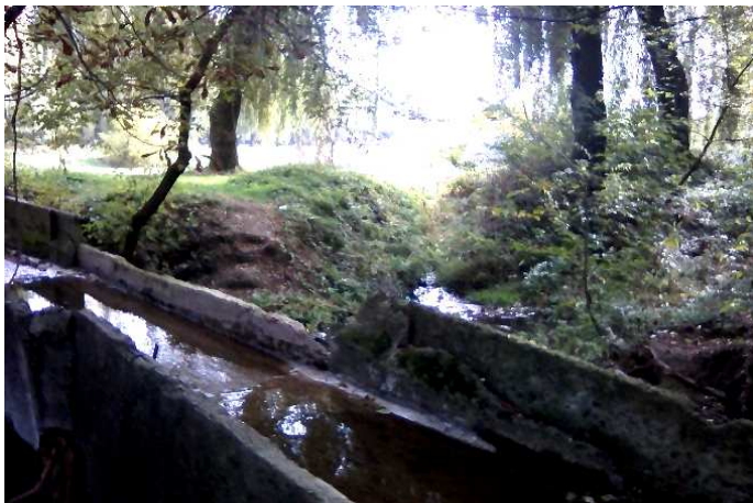
Рис. 5. Бетонний жолоб
