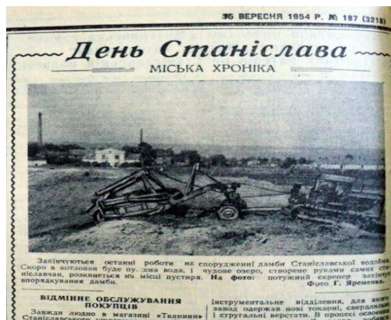
Рис. 1. Будівництво озера в м. Станіслав 15 вересня 1954 року [2]
