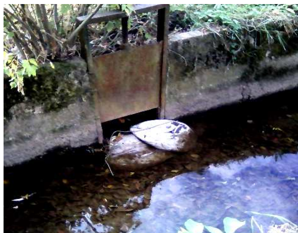
Рис. 4. Перекритий мішками з піском шлюз у відстійник.
