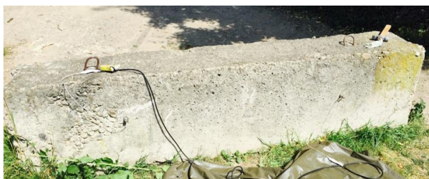
Рисунок 4 – Зовнішній вигляд досліджуваного бетонного блоку
