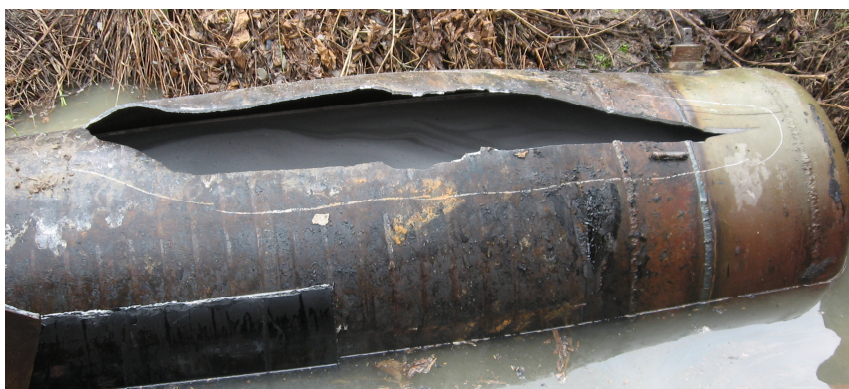
Рисунок 7 – Ділянка руйнування труби
