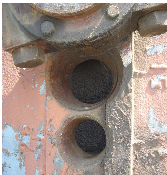
Рисунок 1 – Вузол з'єднання шатуна з кривошипом після експлуатації
