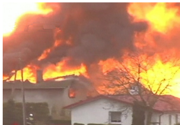
Рисунок 2 – Наслідки аварії мережі газопостачання
