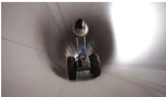
Рисунок 4 – Контроль внутрішньої порожнини трубопроводу самохідною відеокамерою
