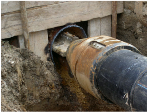
Рисунок 6 – Розширювач для руйнування дефектного металевго трубопроводу
