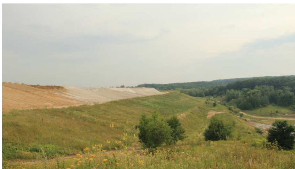
Рис. 2. Загальний вигляд північно-західної сторони діючого фосфогіпсового відвала ПАТ «Сумхімпром»
