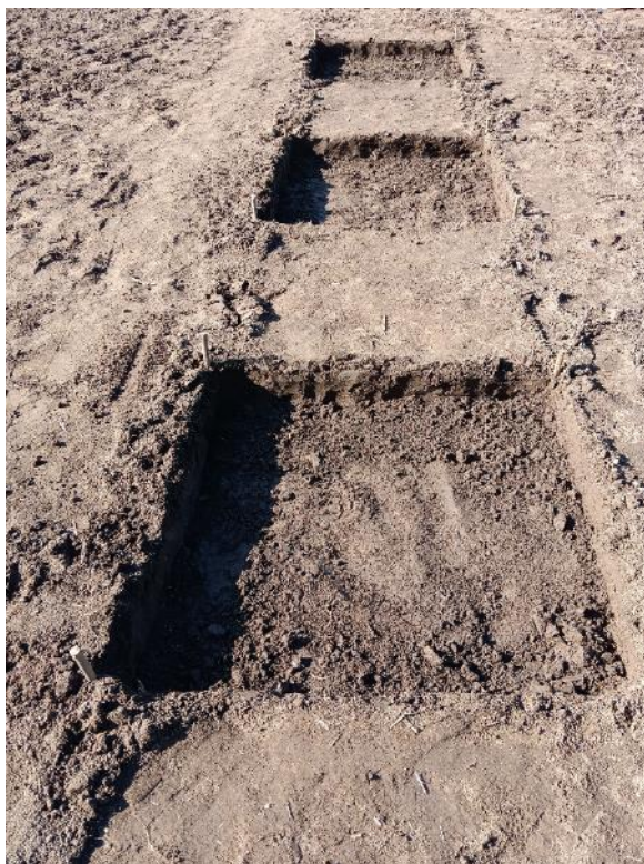
Рис. 5.31. Зняття верхнього родючого шару ґрунту для моделювання процесів рекультивації
