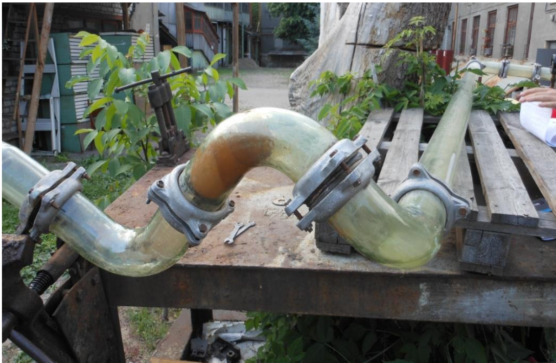
Рисунок 3.5– Проходження поршня в порожнині трубопроводу
