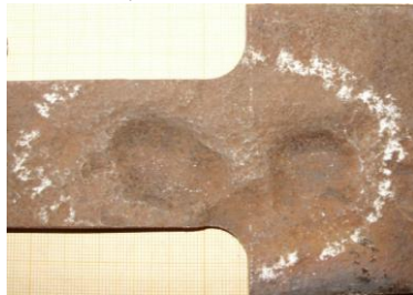
Рисунок 12 – Зразок з локальними ерозійними дефекти внутрішньої поверхні труби
