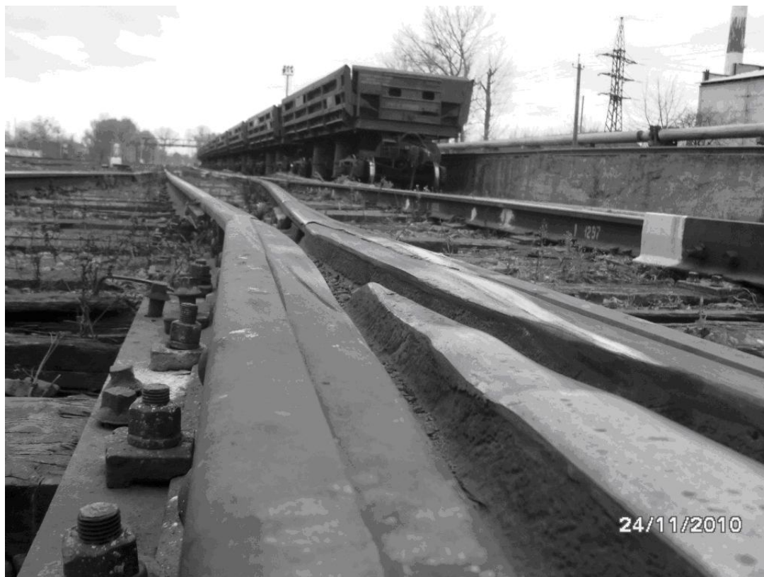
Рисунок 1 – Спрацьовані частини елементів хрестовини
